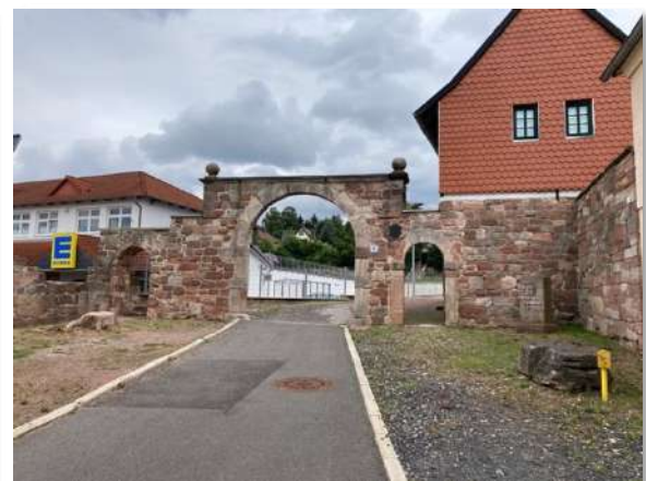
Foto 52: ehem. Torbogen und Zugang zum Fröbelhof 5
