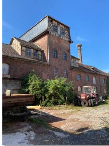
Foto 18: ehem. Mühlengebäude Wilhelmstraße
