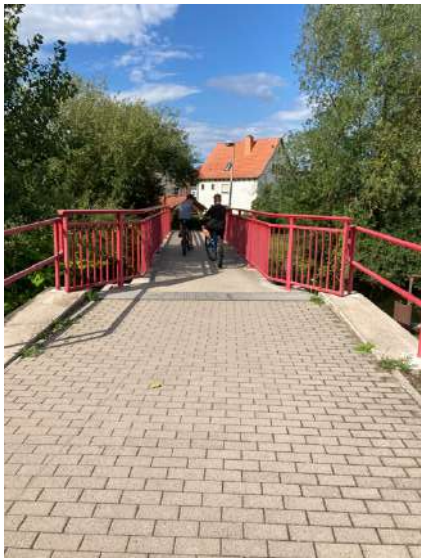
Foto 37: Rad-Gehwegbrücke zur Werra-Insel Auf der Heerstatt
