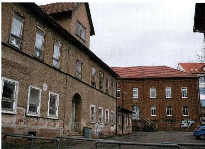
Foto 27:: „Weiße Schule“, Abbruch ehem. Speisesaal 2008
