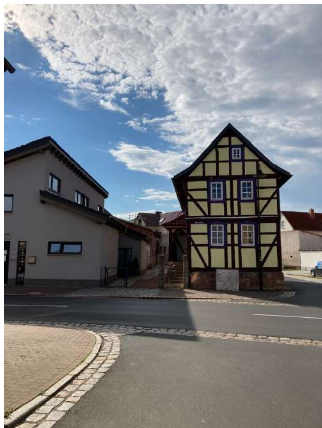
Foto 15: versetztes Pultdach anstelle historischer Giebeldachstellung
