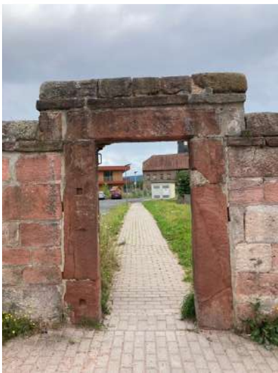
Foto 53: Zugang Mauer ehem. Fröbelhof Richtung Multifunktionsfläche
