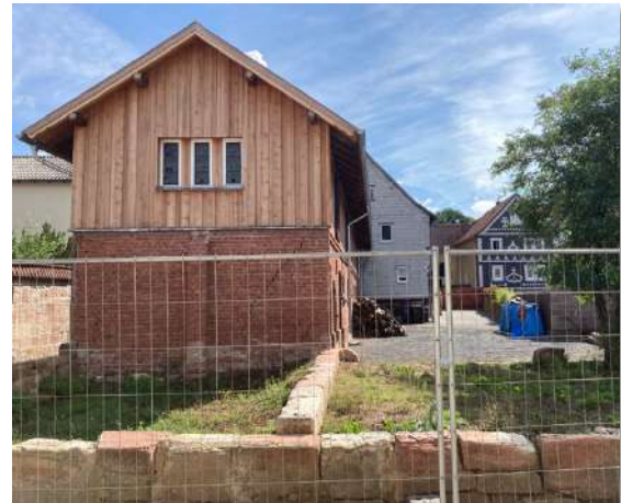
Foto 71: Krug'sches Haus, Abbruchstelle ehem. Scheune
