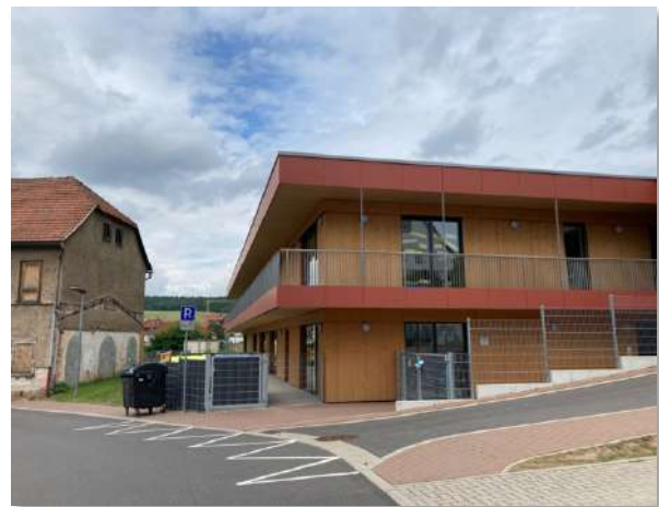
Foto 48: Eingang zum Kindergarten als Mülltonnenstandplatz
