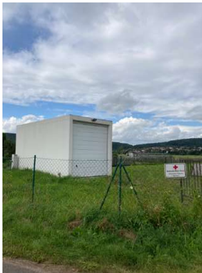
Foto 42: störendes Garagengebäude der DRK Am Flutgraben/ Werra-Altarm
